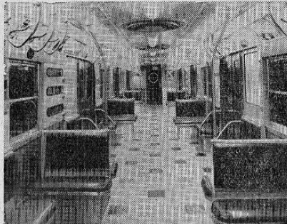
He aquí uno de los modernos carros subterráneos que se usan ahora en la Ciudad de Nueva York. Llevan hasta 200 pasajeros. Con equipo de propulsión General Electric puede desarrollar hasta 50 mph.
